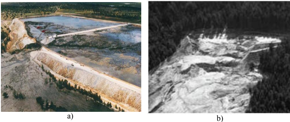
Figura 6.20. a) Rotura de la presa para residuos mineros en Stava, Italia, http://www.stava1985.it , y b) Presa para residuos de metales pesados en Aznalcóllar, España, http://www.wise-uranium.org .
