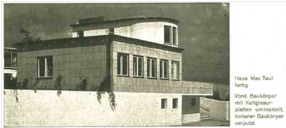
Casa Max Taut acabada. Es destaca l'acabat de plaques esmaltades. a Wie Bauen - Arxiu Subirana
