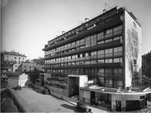
Façana Edifici Clarté - Font Urbipedia
