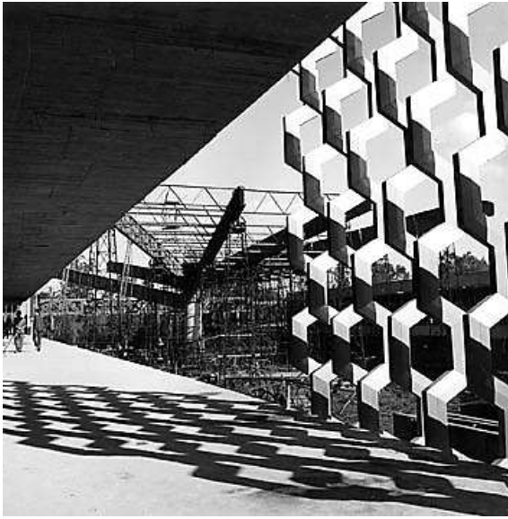
Figura 45. Museo en construcción
