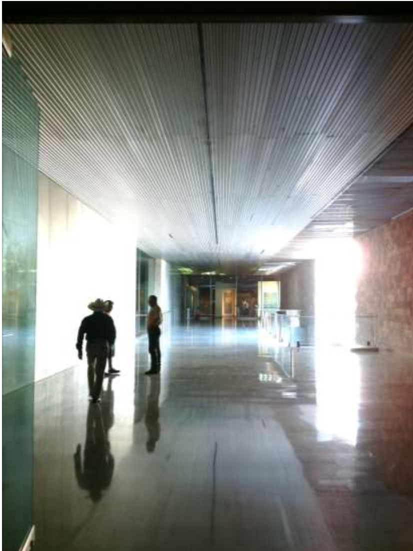
Figura 81. Plafón de área de circulación
