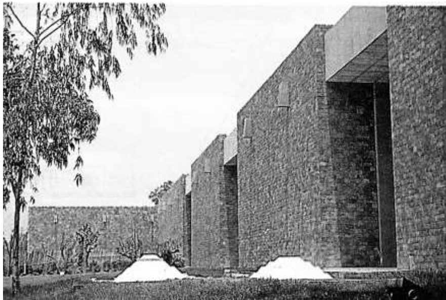
Figuras 141 y 142. Fotos de los muros
