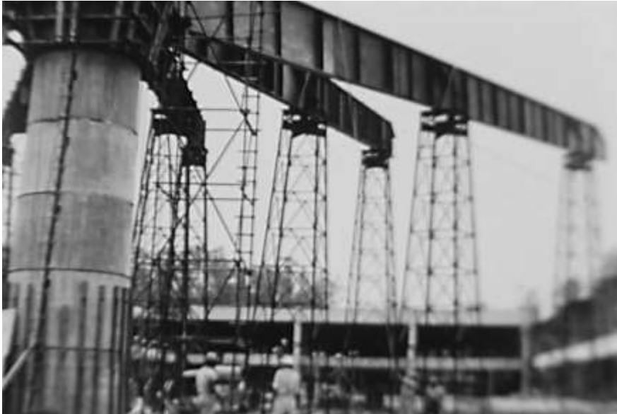
Figura 137. La estructura del Paraguas
