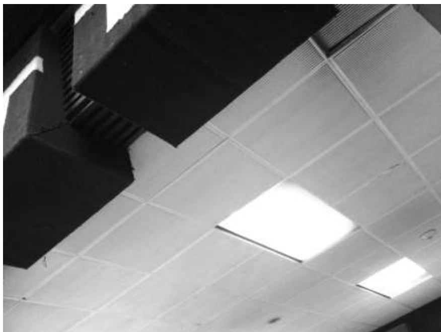
Figura 66. Fotografía del plafón área de servicios y oficinas
