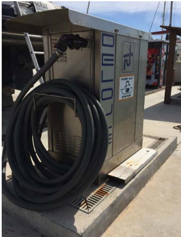
*Figura 4.89: Instalación de recepción de aguas sucias en puerto deportivo. Fuente: Propia*
