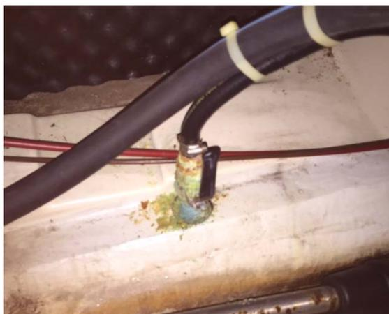
Figura 4.33: Grifo de fondo en mal estado sulfatado. Fuente: Propia
