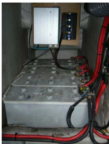
Figura 4.53: Conexión de baterías. Fuente: Propia
