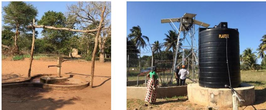
Figura 7. Tipo de pozos bomba manual y bomba con placas solares.
