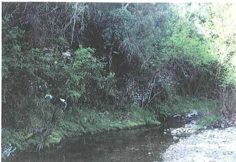
ELS MURS MANTENEN LA COTA DEL REC RESPECTE DEL CURS NATURAL AIGUES AVALL DE LA RESCLOSA
