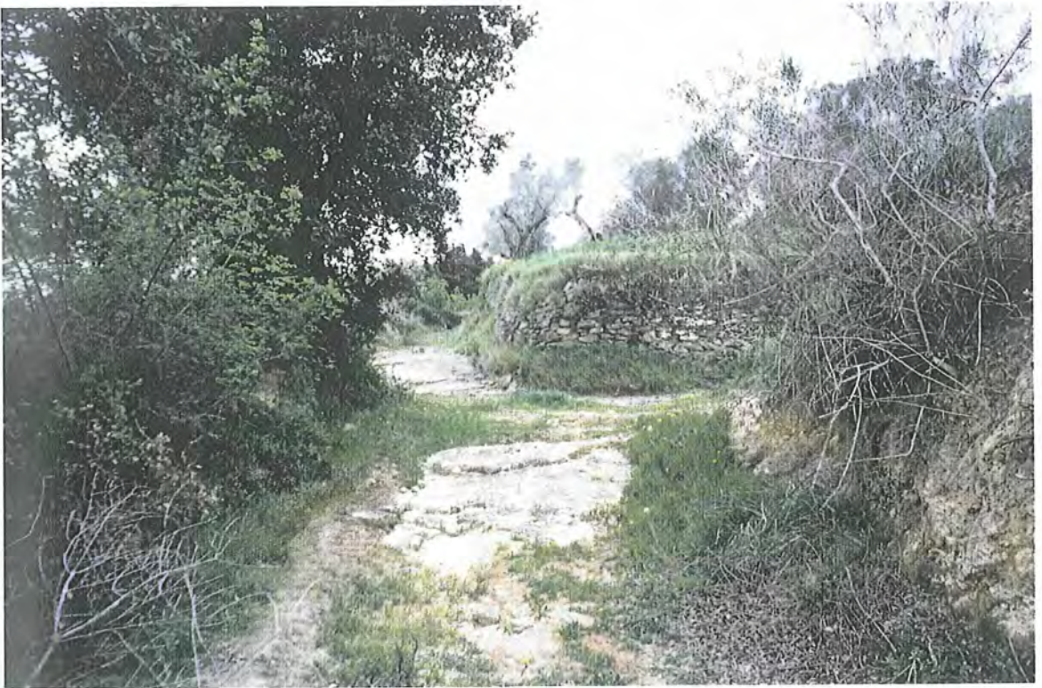
L'ESTABILITZACIO DE LA TRAÇA DEL CAMI.
