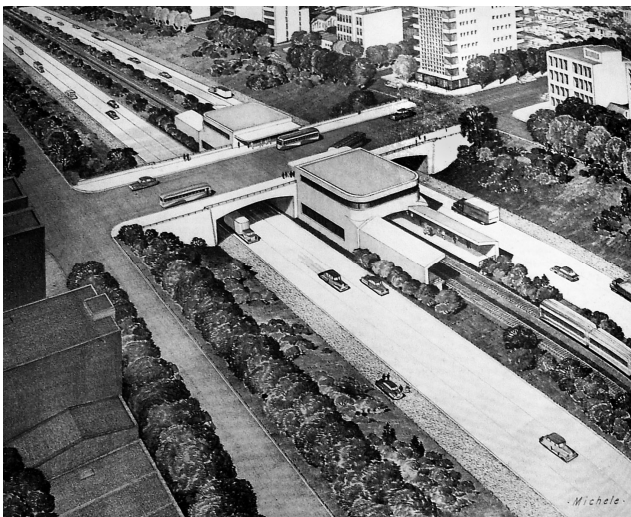
fig 15 - Modelo de rodovia expressa, com faixa central para os ônibus e cruzamento em desnível.
