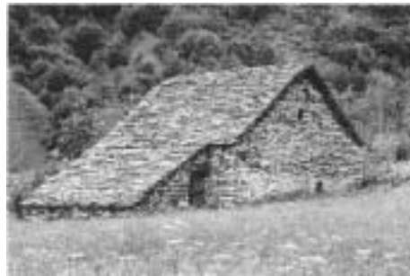
Figura 42. Vivienda de Piedra, Val Verzasca.
