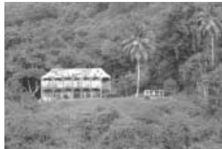
Figura 48. Vivienda de Estructura Ligera de Madera, Caribe.
