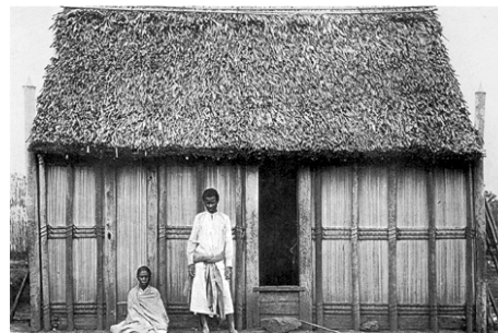
Figura 49. Vivienda de Madera y Paja, Estructura Ligera y Permeable, Madagascar.
