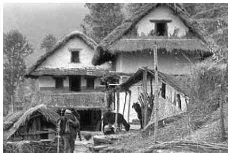
Figura 43. Vivienda de Madera, Tierra y Paja, Aisa.
