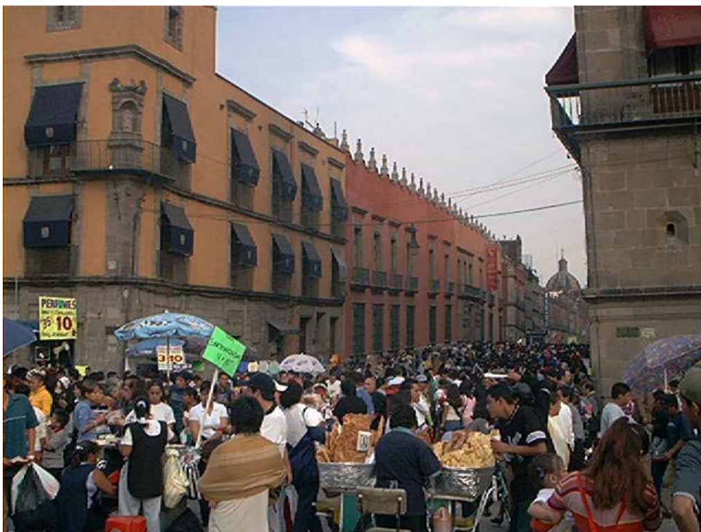
(Fig. 10) Fuerte deformación en las mamposterías de los edificios.
