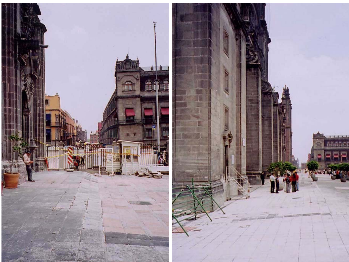
(Fig.2 y 3) Hundimiento diferencial del atrio de la Catedral Metropolitana.
