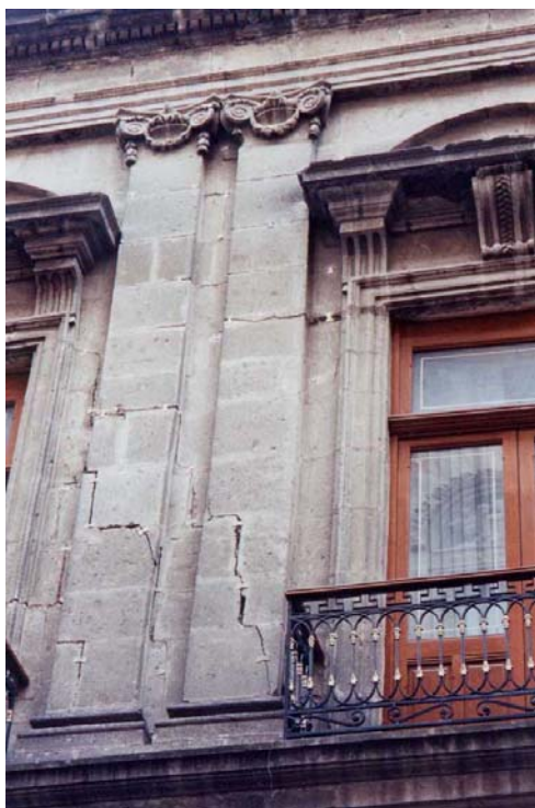
(Fig. 11) Detalle de grietas por los fuertes asentamientos diferenciales del suelo (Fig. 12) Palacio de Minería (restaurado durante 1973-1976).
