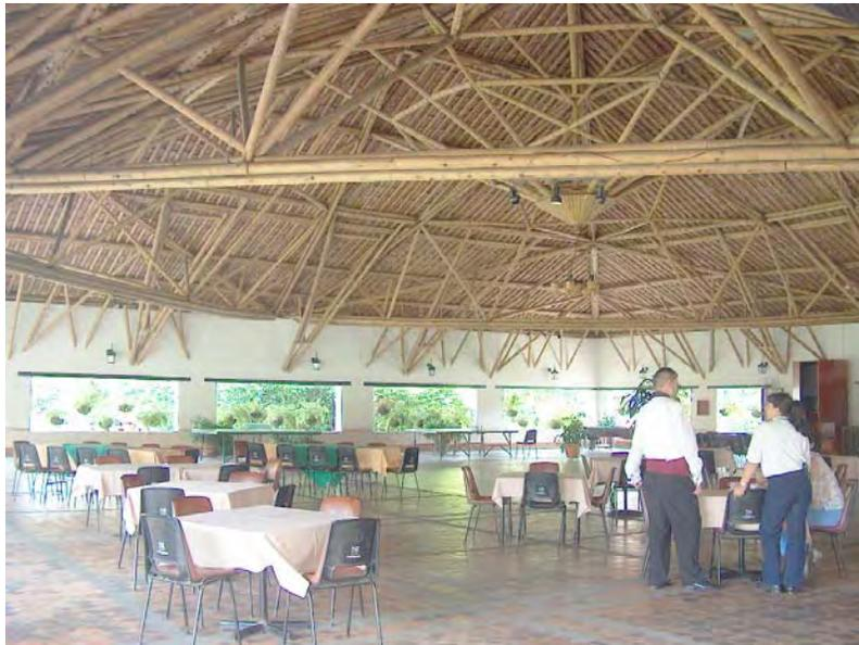
275. Vista de la estructura de la cubierta en guadua (foto del autor)
