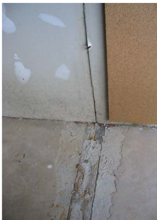
Fotos de les juntes interiors entre mòduls que s'han de resoldre a l'obra. C.E.I.P. Garigot de Castelldefels.
