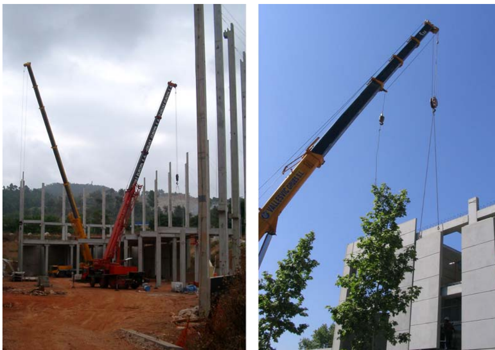
Fotos del muntatge de l'estructura i la façana.
