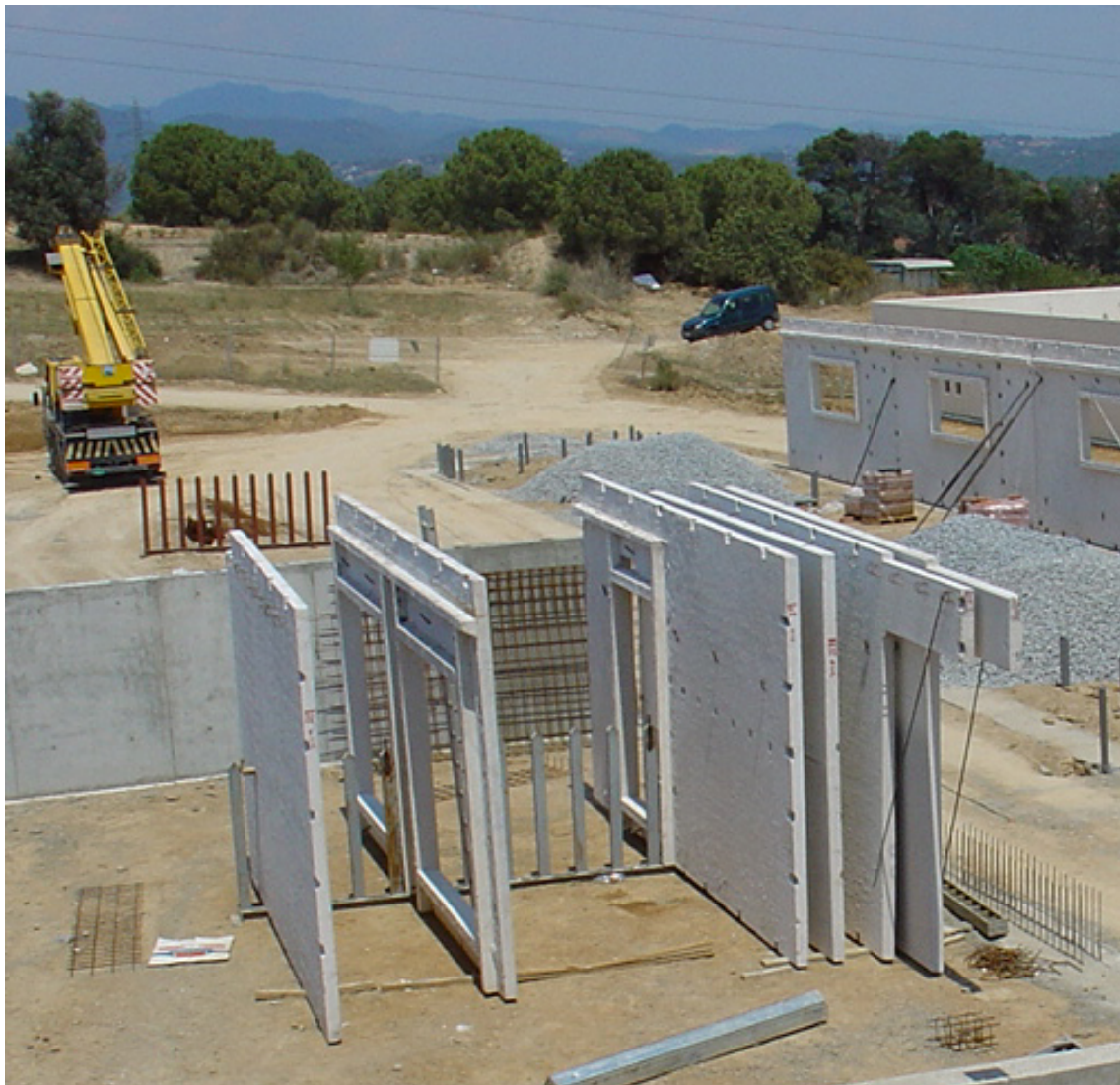
Fotos de l'aplec dels murs portants de façana del C.E.I.P. Vinya del Sastret de Sant Esteve Sesrovires.
