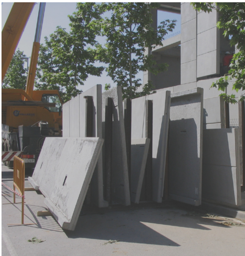
Fotos de l'aplec a l'obra dels plafons de façana.
