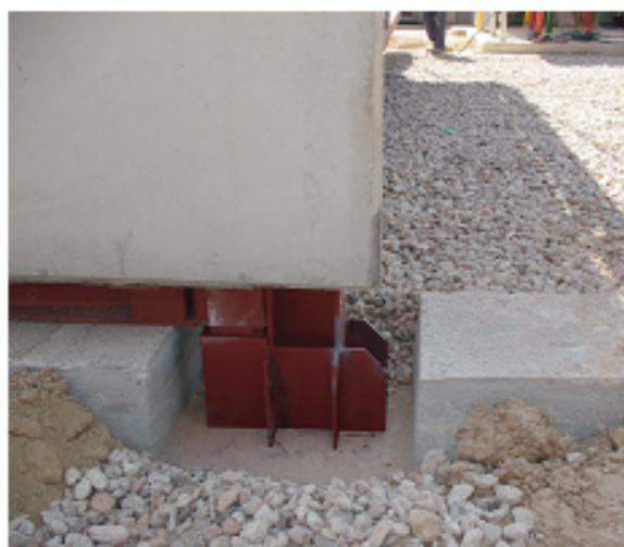
Fotos del procés d'unió dels mòduls amb els fonaments del C.E.I.P. Garigot de Castelldefels.
