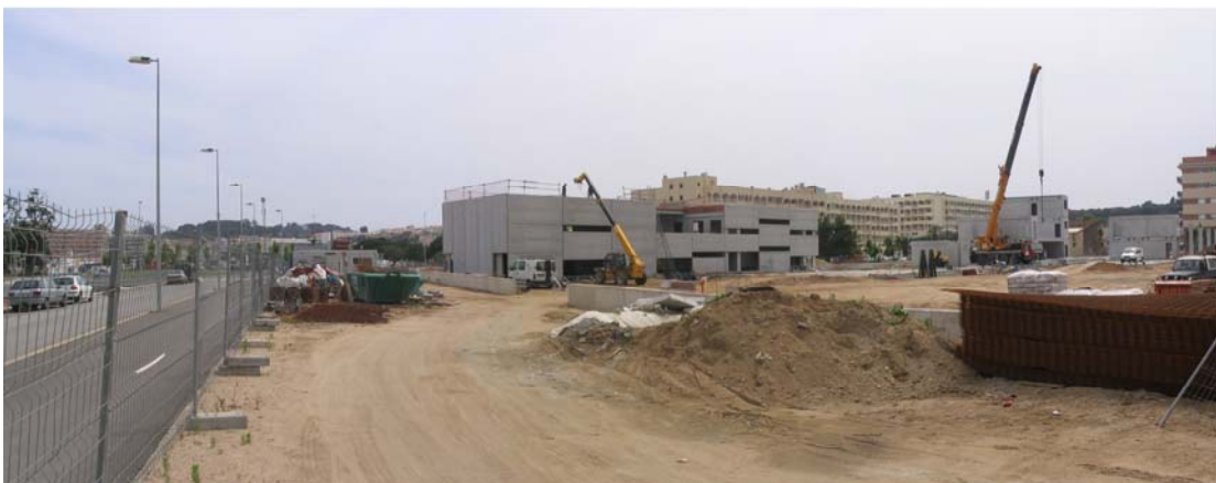
Fotos de la construcció del C.E.I.P. Àngels Alemany de Lloret de Mar cedides per Pich-Aguilera Architects.
