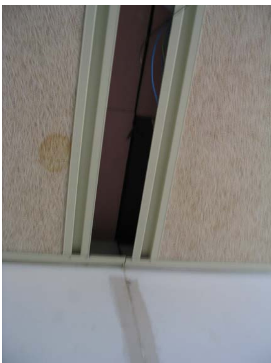
Fotos de les juntes interiors entre mòduls que s'han de resoldre a l'obra. C.E.I.P. Garigot de Castelldefels.
