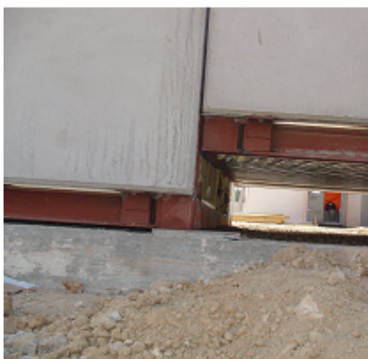
Fotos del procés d'unió dels mòduls amb els fonaments del C.E.I.P. Garigot de Castelldefels.
