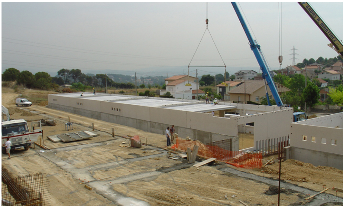
Fotos de la construcció del C.E.I.P. Vinya del Sastret de Sant Esteve Sesrovires.
