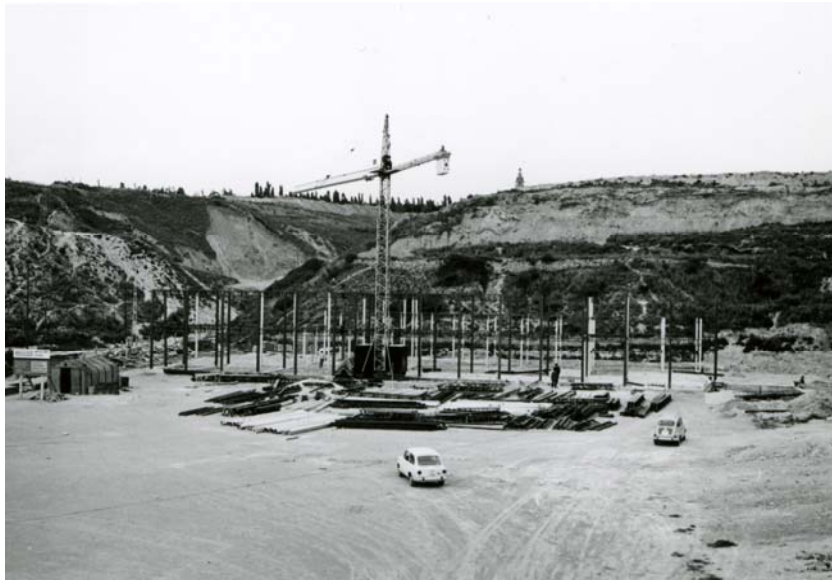
Foto de la construcció de l'escola Can Clos de P.L.Espinosa.
