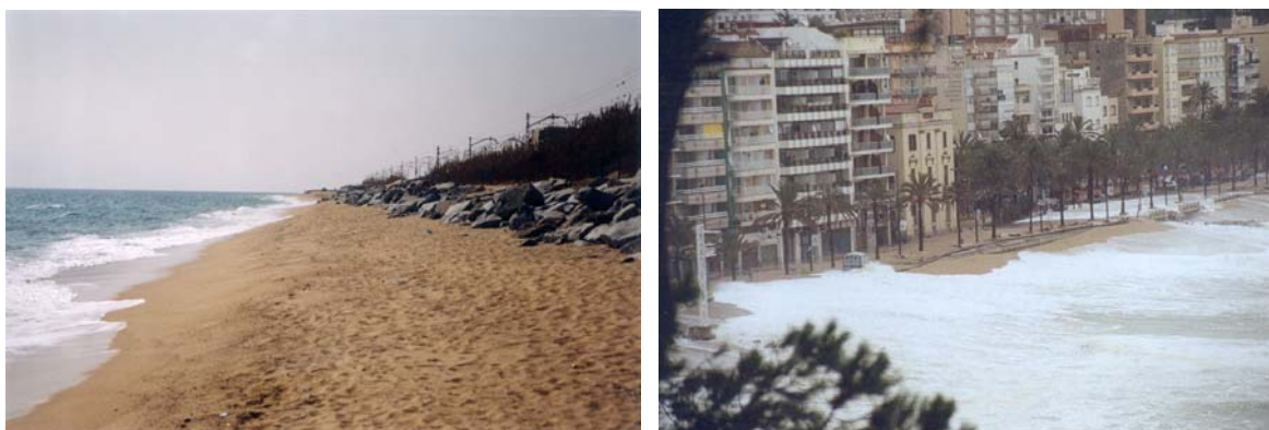
Figura 2.2.4. Izquierda : disminución de la capacidad de protección de la playa de Cabrera de Mar por erosión. Derecha : exceso de la capacidad de protección de la playa de Lloret durante el temporal de Noviembre de 2001.
