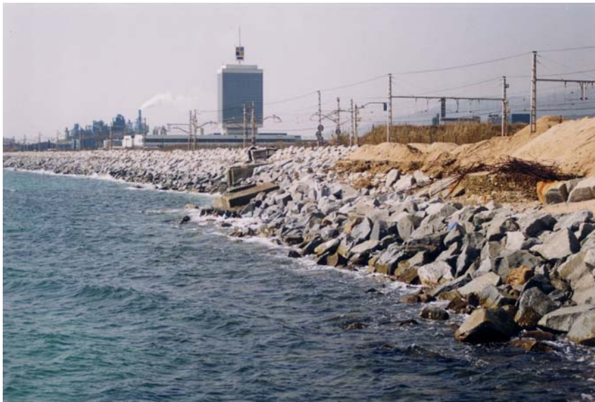
Figura 2.2.2. Muro longitudinal de protección de las vías del tren a lo largo de la costa del Maresme, justo aguas abajo del Port de Mataró.
