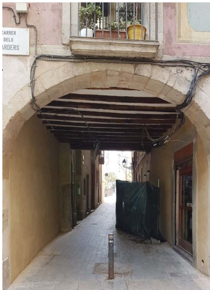
Figura 47. Entrada a la calle Muntanyans. Autor: J. M. Solís. Fecha: Febrero 2017
