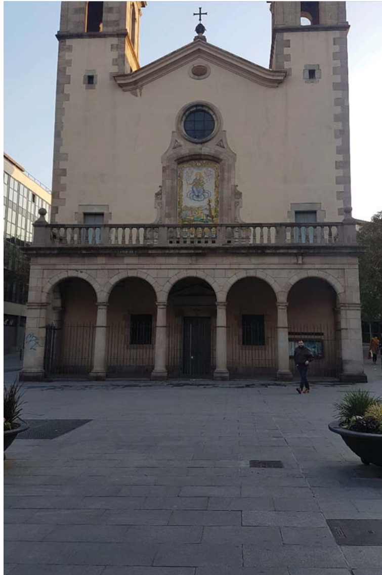
Figura 19. Iglesia de San Pedro Nolasco con la zona diáfana delante. Autor: J. M. Solís. Fecha: Febrero 2017.
