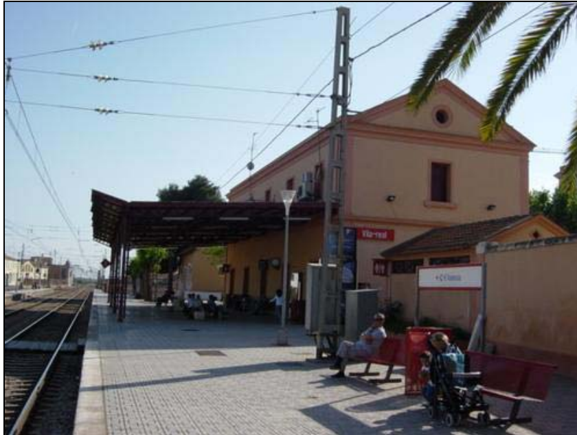
Fig II.9.3.2 Estación de ferrocarril de Vila-real
