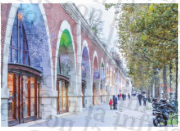
(F32) "Whitworth Street West", Arcos del viaducto. MSJ Manchester, 1964.
