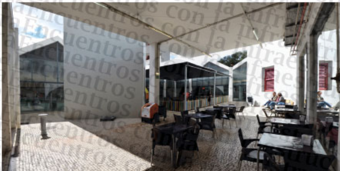
(F29) Patio del mercado de Alcántara con las bases del pilar 14 del Viaducto de Alcántara. Lisboa, 2018.
