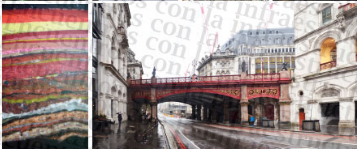
(F21) Capas de pintura y alzado principal de la estructura de diagonales prefabricadas del cajón ferroviario de Sants, ramet allica, Timpanos, barandillas y cornisas d'ecoradas, Lombres, 2017.
