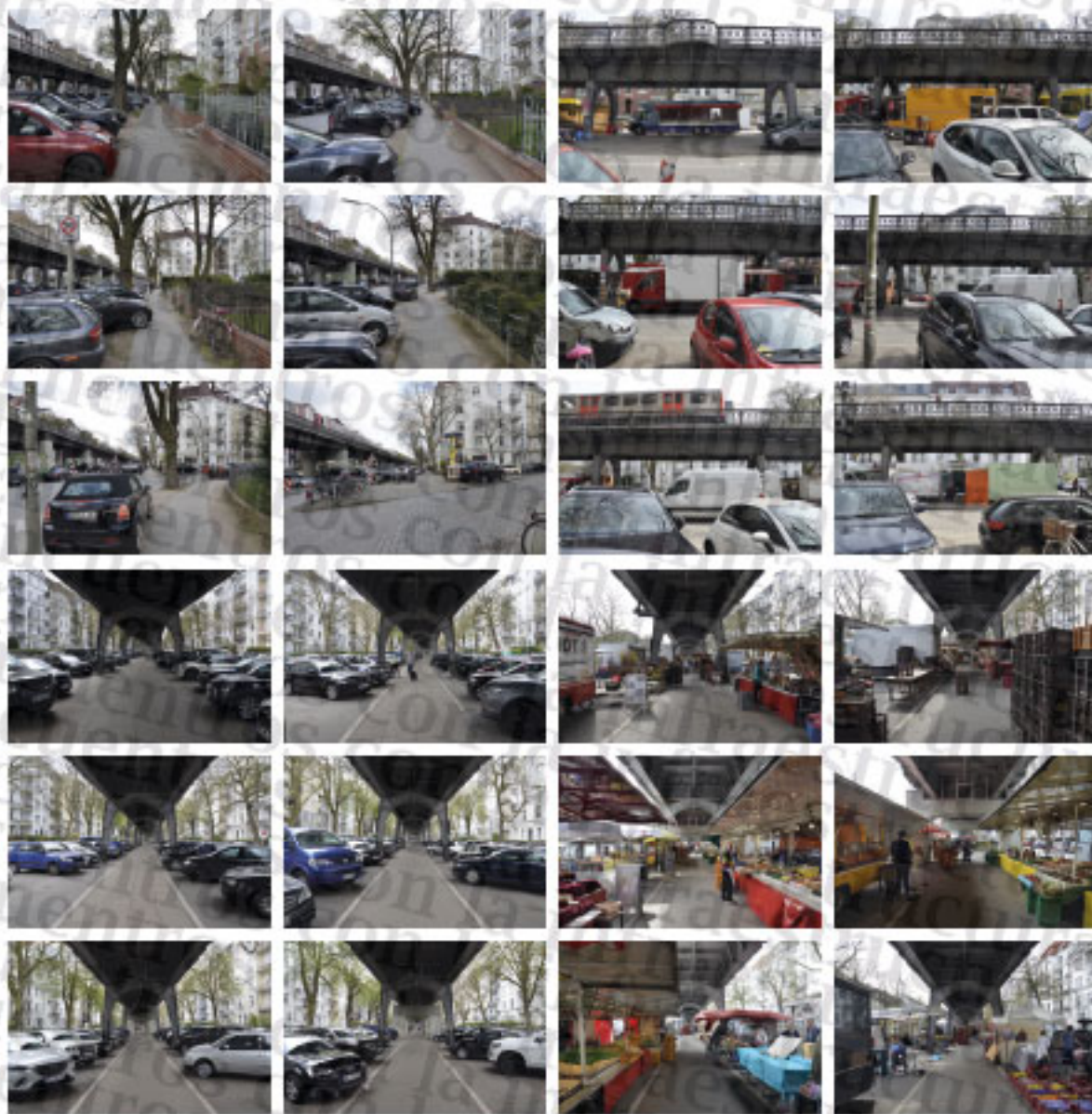
(F01) Secuencia de fotografías (lateral, frontal, central con aparcamiento y central con mercado) alrededor del viaducto de Isestrasse en Hamburgo, 2016.
