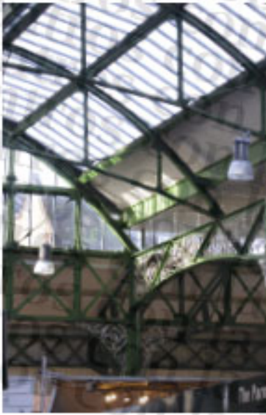
(F09) Reflejos intermitentes de paso de trenes en el interior del Borough Market, Londres, 2016. (F10) Sombras del Viaducto de Alcántara sobre las viviendas de R. Leão de Oliveira, Lisboa, 2018.
