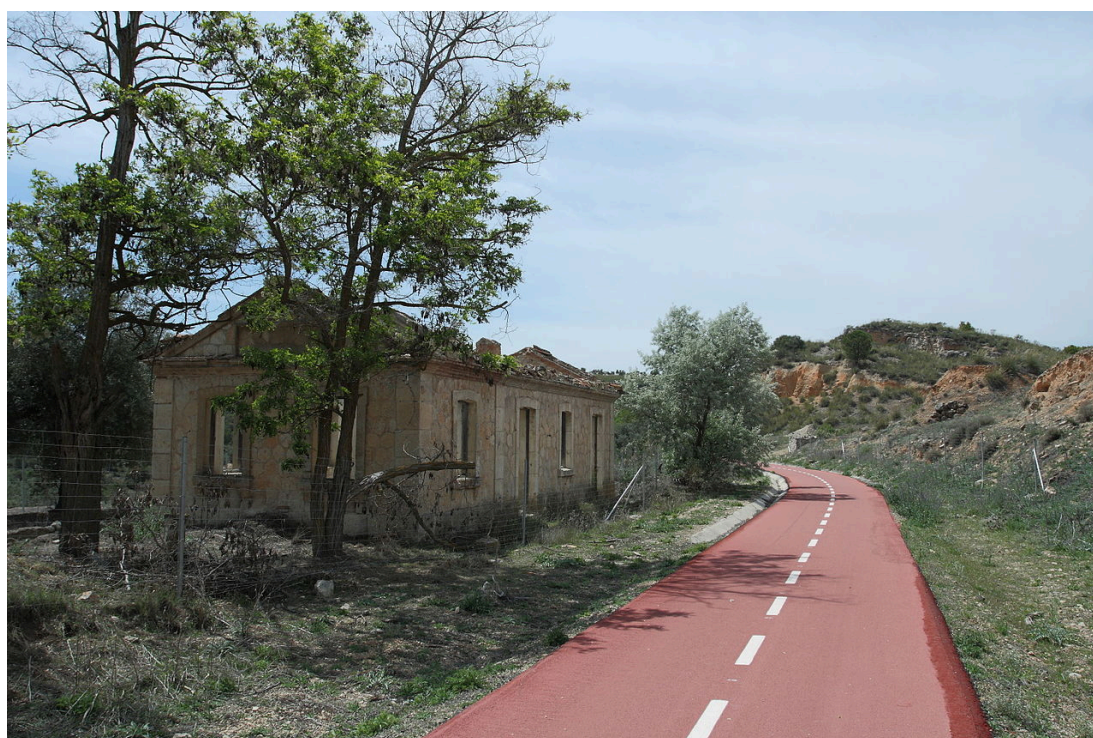
Figura 2: Trazado y estación en la línea del Ferrocarril del Tajuña reconvertido en vía verde
