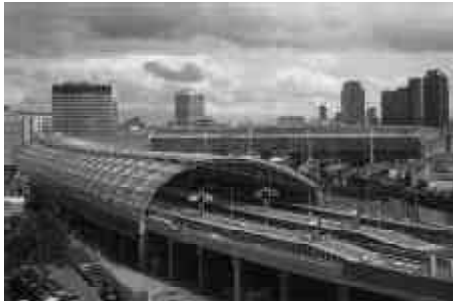
Grimshaw, Estación de ferrocarriles Waterloo, 1994. (Grimshaw, 1994, p. 41).
