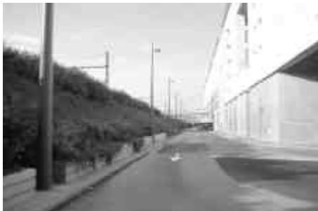
Fachada lateral oeste y vía de autobuses del Pole Multimodal Gare de Vaise, Lyon, 1997. (Foto: Albornoz, Boris, 1999.)
