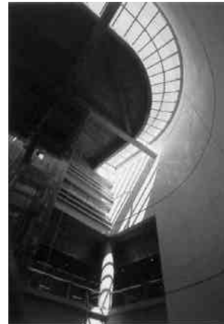
Petit, Vista interior del ducto de luz. Pole Multimodal Gare de Vaise, Lyon, 1997. (SYTRAL, 1997, p. 15.)
