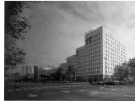
Moneo, Solà-Morales, Centro Comercial L'illa Diagonal, vista entre Diagonal y Numancia, Barcelona, 1992. (Moneo, 1994.)
