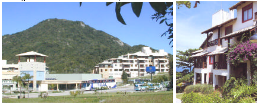
Figura 294 – Cubierta Centro de Comercio y Deportes y de las Villas. (F.: Fundação Franklin Cascaes e Paulo Edi)
