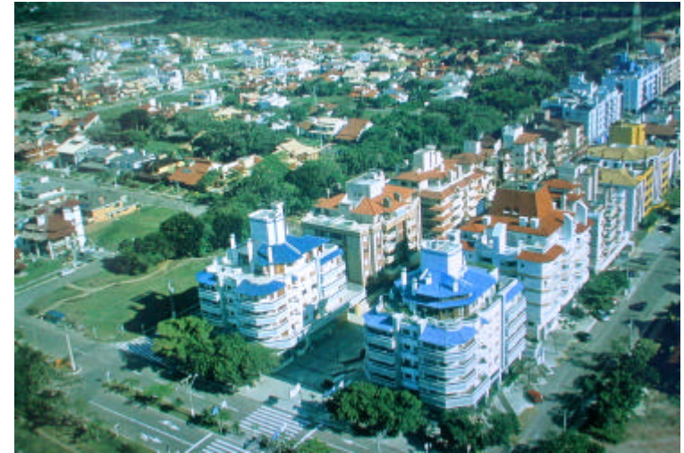
Figura 234 – Bloques Multifamiliares y zona comercial Open Shopping. (F.: Fólter promocional Habitasul)
