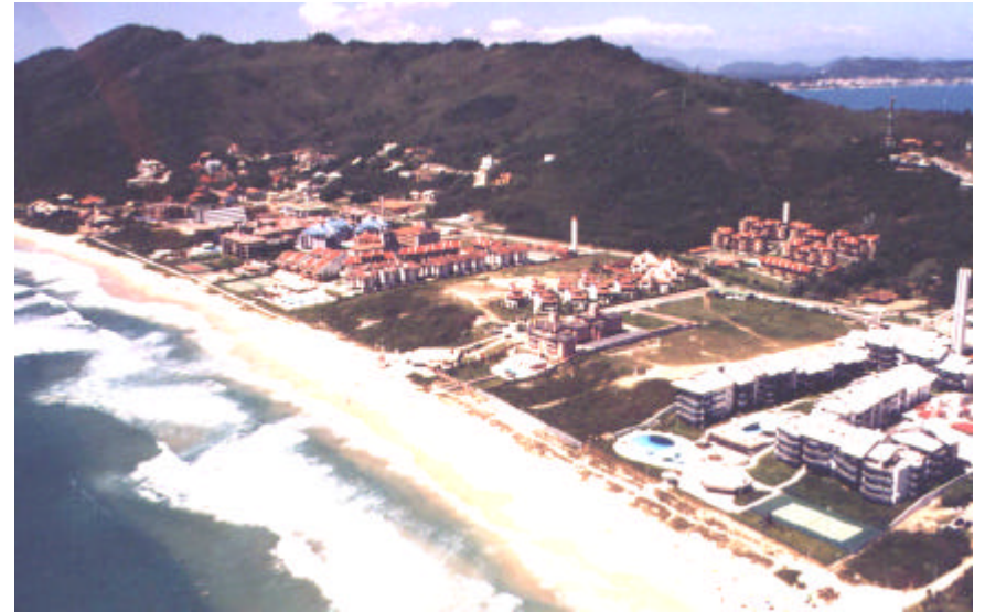
Figura 264 - Año 2000: todos los lotes edificados ocupan la faja de área verde pública, con equipamientos privados.(F.: Paulo Edi-2001)
