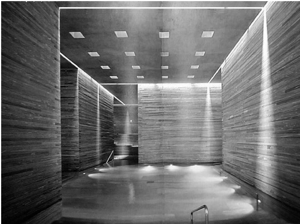
Foto 19: La piscina interior es el corazón del edificio. Las cubiertas voladas giran en torno a este espacio para soportar a su vez la cubierta "flotante" para derramar luz en todo su perímetro. Esta pieza también está perforada para dramatizar aun más el contraste entre penumbra y claridad, dando un efecto casi sacral a este espacio.
