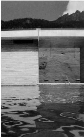
Foto 20: Las formas puras, el manejo de las texturas y colores de los materiales, la colocación en el lugar destacan claramente el carácter escultórico del edificio como una de sus vertientes expresivas.
