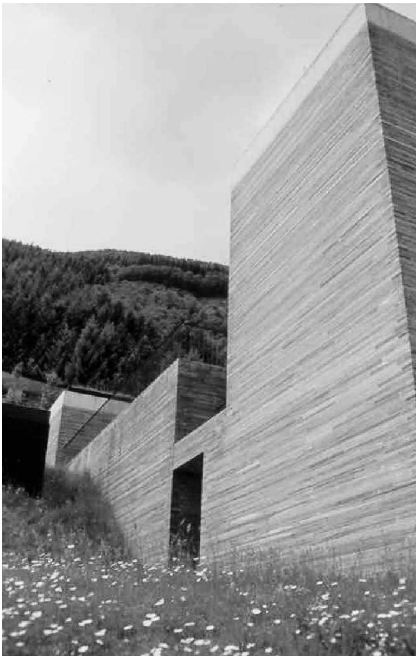
Foto 18: Las formas puras, el manejo de las texturas y colores de los materiales, la colocación en el lugar destacan claramente el carácter escultórico del edificio como una de sus vertientes expresivas.
