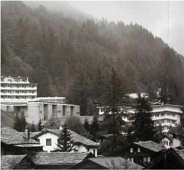
Foto 2: Vista general del conjunto de hotel y baños termales.
