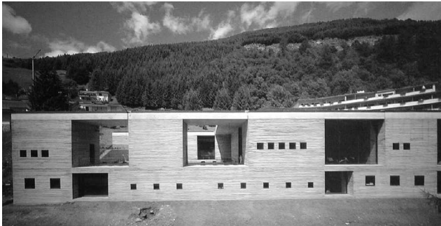
Foto 4: Vista de la fachada principal (fachada oriente) de los baños, donde se alternan grandes perforaciones de proporción cuadrada, con pequeñas ventanas.
