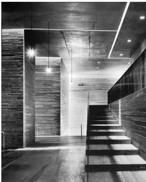
Foto 5: Vista del interior donde pisos y muros de piedra dominan el ambiente, matizado por una penumbra controlada. Las juntas se forman por losas independientes en cantiliver, apoyadas cada una en un bloque macizo de concreto y piedra.
