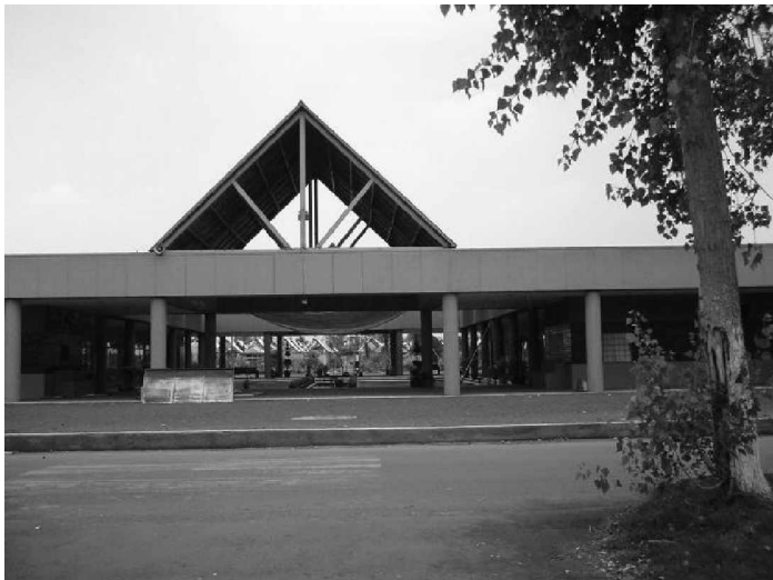
Foto 2: Vista del edificio administrativo del mercado de flores, con su patio central y dos crujiás libres para formar los pórticos de acceso.
