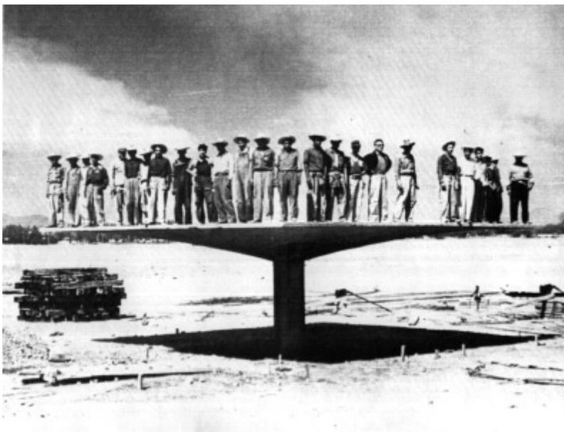
**Figura 40.** Pruebas de Resistencia. Paraguas de hormigón de Félix Candela. (1953)
