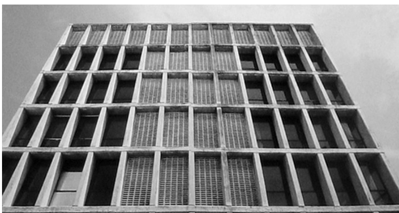
Figura 68. Universidad de Bagdad. Irak 1957. Walter Gropius. PROBST, Zhädlich. Walter Gropius. Der Architektur und Pädagoge. Berlin: Ernst & John
