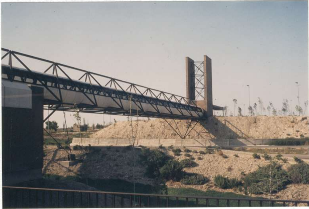
El puente de acero de la imagen superior es un ejemplo de la ingeniería moderna y del uso de materiales de alta resistencia. Su diseño permite soportar grandes cargas y resistir las condiciones climáticas adversas.
