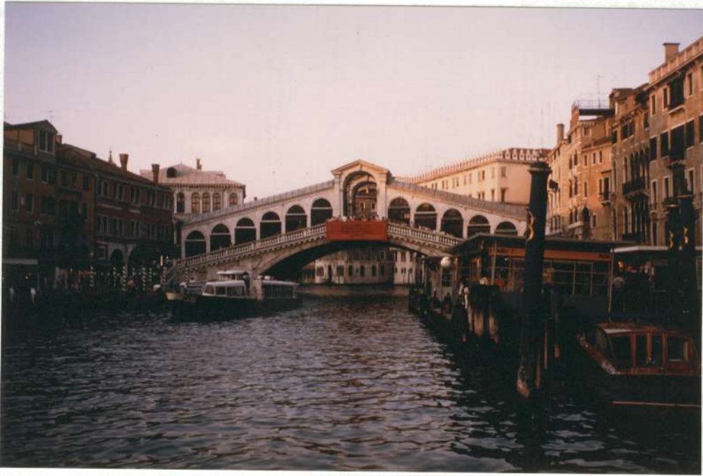
La imagen nos ha enseñado la importancia de la forma. A través de la estructura se crea un espacio del propio espacio arquitectónico en el centro de la ciudad.
