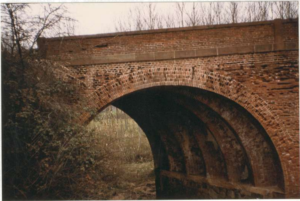
Este tipo de estructuras de ladrillo son comunes en la arquitectura tradicional y han demostrado ser muy resistentes y duraderas. Su construcción requiere un conocimiento profundo de la mecánica de los materiales.
