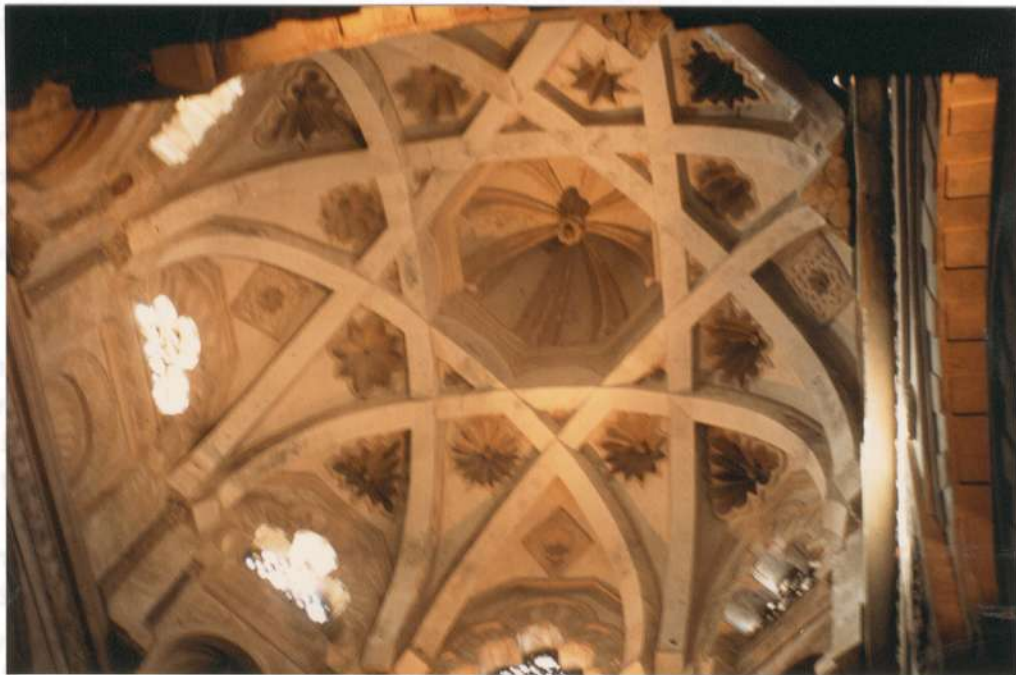
3/2 Cepilla de Villaviciosa o Macsura de la mezquita de Córdoba. La composición de los planos está totalmente independizada de la cúpula cuya composición es una entidad cerrada autónoma.
