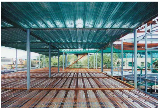
Figura 3-1 Losa mixta en construcción y muestra de montaje
