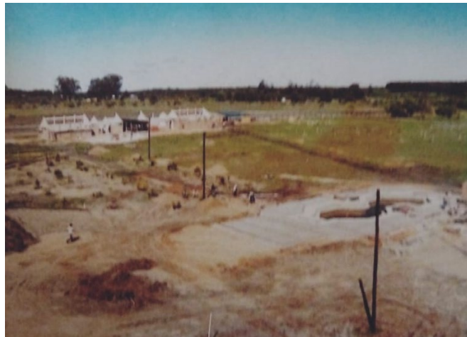
Figura 40. Construcción del Parque Termal Federación (Argentina)
