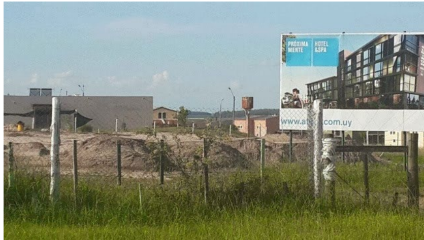
Figura 51. Construcción del primer hotel 4 estrellas en el Centro Termal Almiron (2013)
