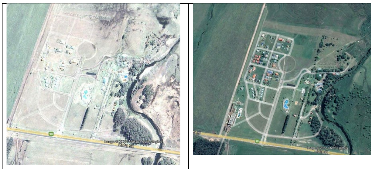
Figura 53. Centro Termal Almirón evolución de construcciones 1985 (imagen izq.) y 2019 (imagen der.)
