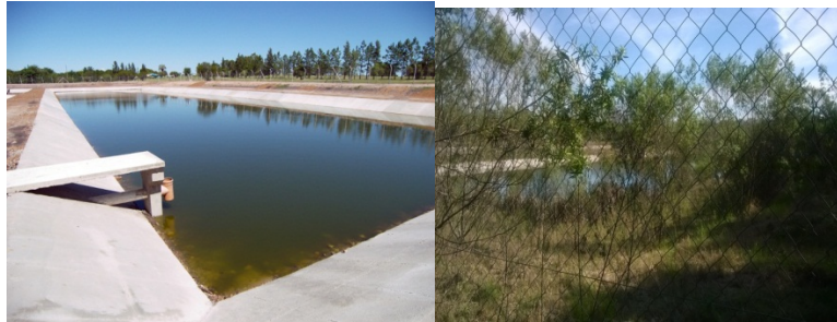
Figura 63. Piletas de decantación (Termas de Guaviyú)
