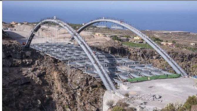
FIG. 18. Viaducto de Erques, Tenerife (España)
