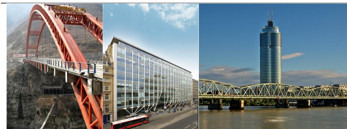
FIG. 3. Ejemplos de aplicación de CFST: Puente sobre el río Gantse, China (izq.), Edificio Fleet Place House, Londres (Inglaterra) (cen), y Torre del Milenio, Viena (Austria) (der.)
