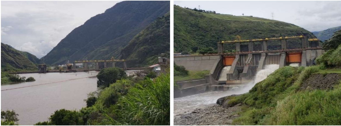
Ilustración 31. Represa y Central de la hidroeléctrica Hidroagoyan - Ecuador
