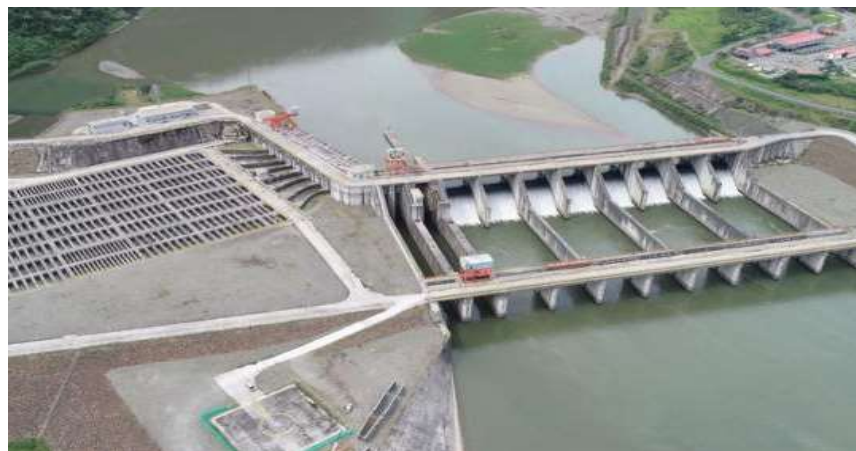
Ilustración 29. Central hidroeléctrica Coca Codo Sinclair - Ecuador Fuente: (Ministry of Energy and Non-Renewable Resources of Ecuador, 2018).
