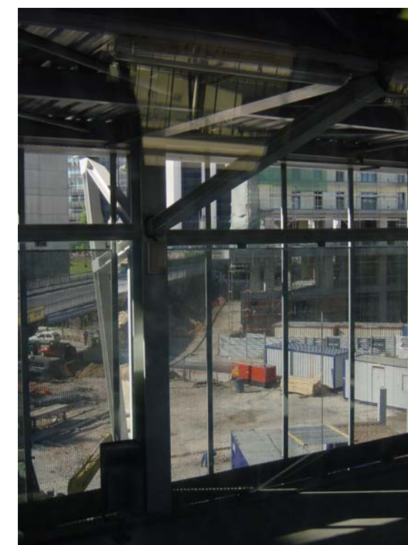
TRAYECTO 4-B | 12.Ferrocarril: Entrecampos-Fogueteiro-03.2000, fotografia S. Morgado. Lisboa: Campolide, Vale de Alcântara.
