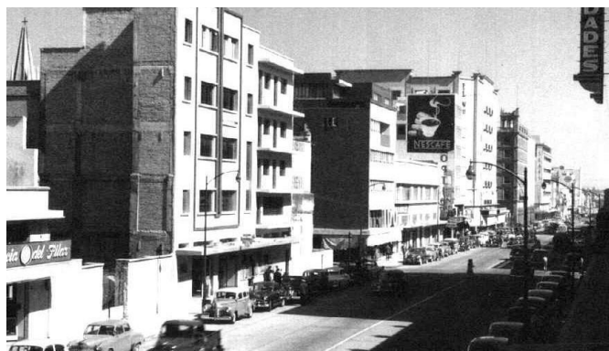
5,36 La avenida en la zona central después de la ampliación con la nueva edificación.
