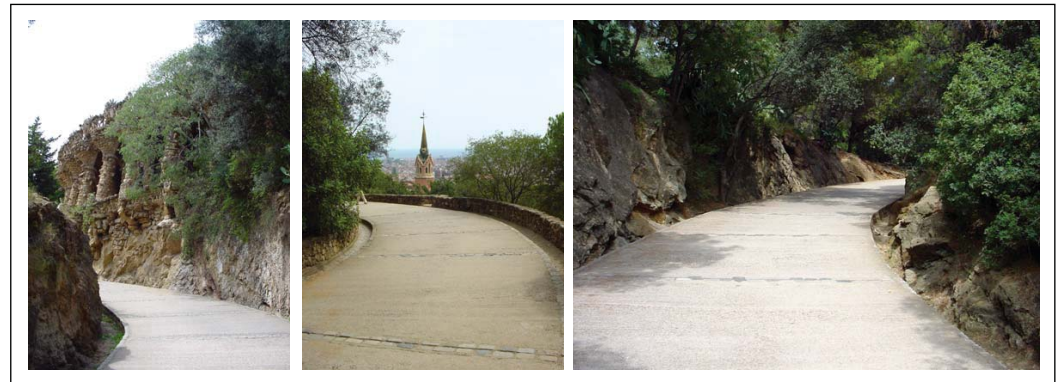
▲ Vials de segona categoria. Aquests recorreguts, que neixen del vial principal de primera categoria de 10 metres d'ample i que connecta l'entrada de llevant amb l'entrada de ponent, tenen tots ells una amplada de 5 metres, i són aptes per als carruatges, disposant per trams d'un eixamplament semicircular de 10 m de diàmetre per poder permetre el gir dels carruatges. Aquest recorregut, de suaus pendents, té diverses seccions en el seu traçat, amb passos elevats i amb trams en trinxera.
