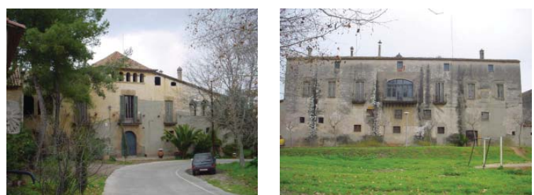
◀ El mas Güell. L'edifici se situa en la part més oriental del sector, i mostra una façana principal orientada a sud molt més expressiva que la sobrietat de la façana situada a nord, i que dona front al camp d'esports.
