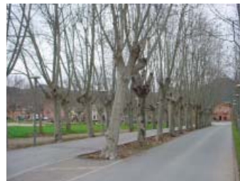
▲ L'avinguda d'accés. Tres rengleres de plataners singularitzen la via d'accés a la colònia, i recolzen el vincle entre l'àrea residencial i la fàbrica.
