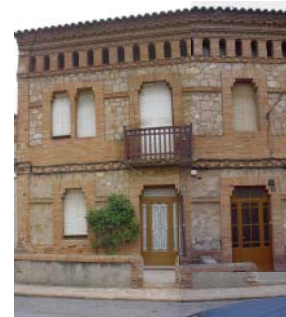
◀ La façana tipus. Els habitatges en filera utilitzen també el maó massís ceràmic, combinat però amb aplacat de pedra.
