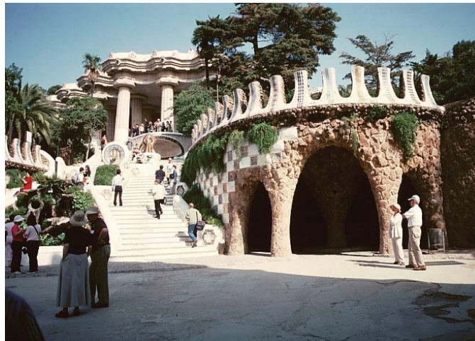
▲ La cotxera. Aquesta construcció preveia la protecció dels carros, que giraven al voltant d'una columna situada en l'interior i que, al mateix temps, amagava una canalització de recollida d'aigües que s'abocaven a un dipòsit situat a un nivell inferior.
