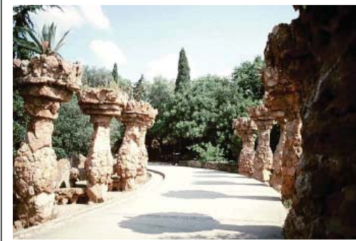
▲ Suports de la via de segona categoria. En el tram sinuós situat a llevant, el vial se sustenta per pilars inclinats que recullen recorreguts peatonals, considerats en la memòria del projecte de tercera categoria.
