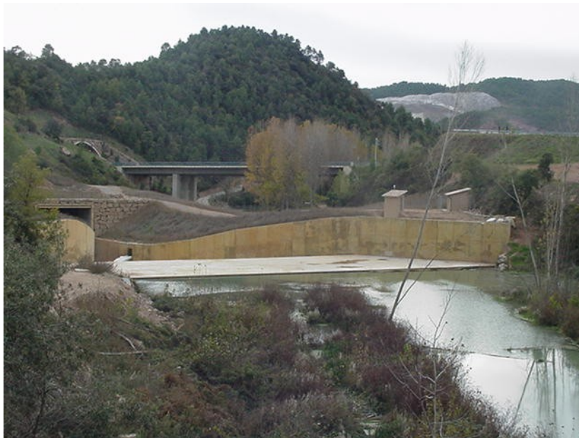
Figura núm. 108. Desviament del riu Cardener a través d'un túnel pel coll del meandre del Cardener abans de la confluència amb la vall Salada
