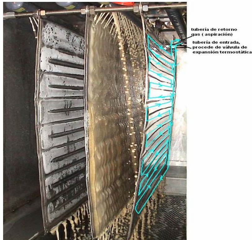
Fotografia 3.8. En blau, recorregut que segueix el refrigerant dins les plaques
