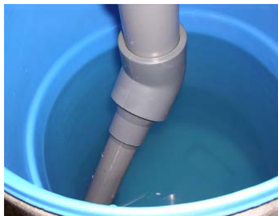
Figura 3.8. Esquema i fotografia de detall de la peça de buidatge
