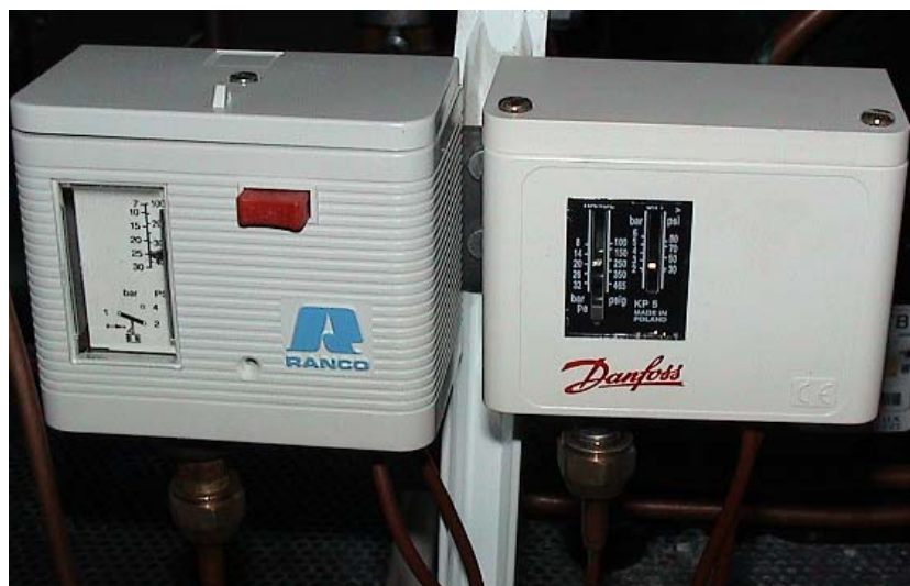
Fotografia 3.15. A l'esquerra, pressòstat per a la fi del desglaç. A la dreta, pressòstat de control del cicle de ventilació
