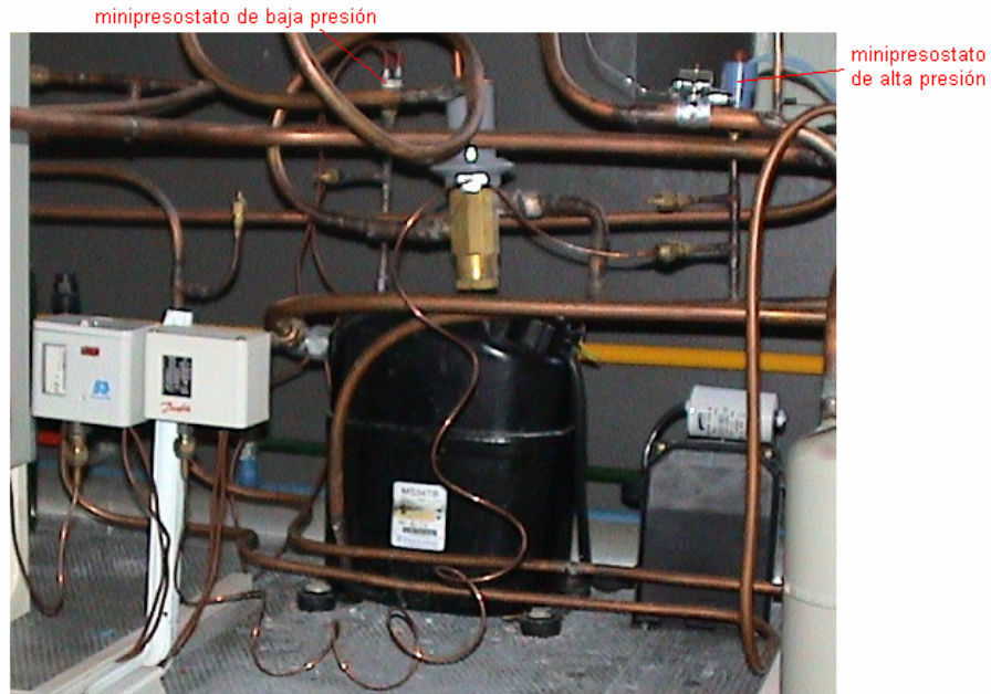
Fotografia 3.16. Minipresòstats d'alta i baixa pressió
