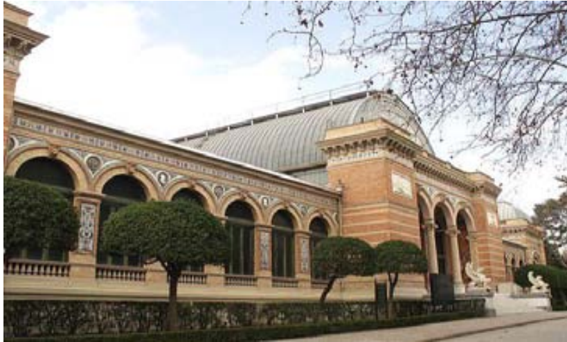
Ilustración 9.6. Vista exterior del Palacio de la Minería (Fuente: fotografía de José Luis de Diego, 2007).
