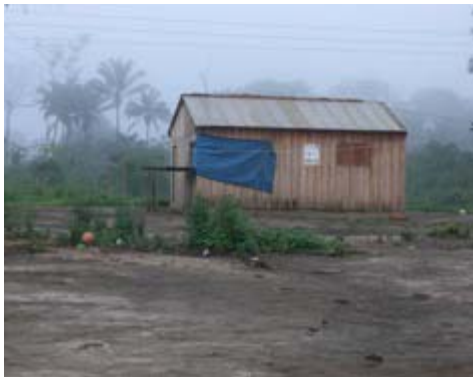
3. Casa de Varrevento y tendido eléctrico
