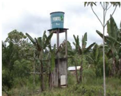
30. Depósito de agua
