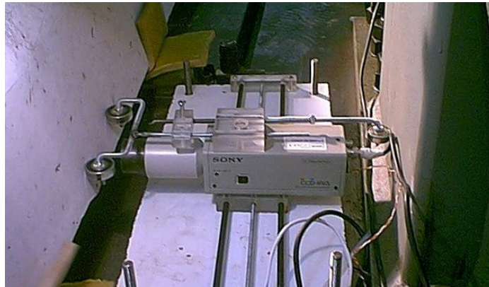
Figura 5.34. Medición de las fisuras sobre la traviesa
