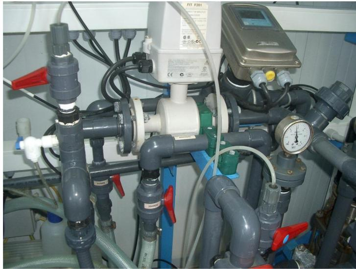
Figura VI.10 Situación de las válvulas de dosificación de ácido
