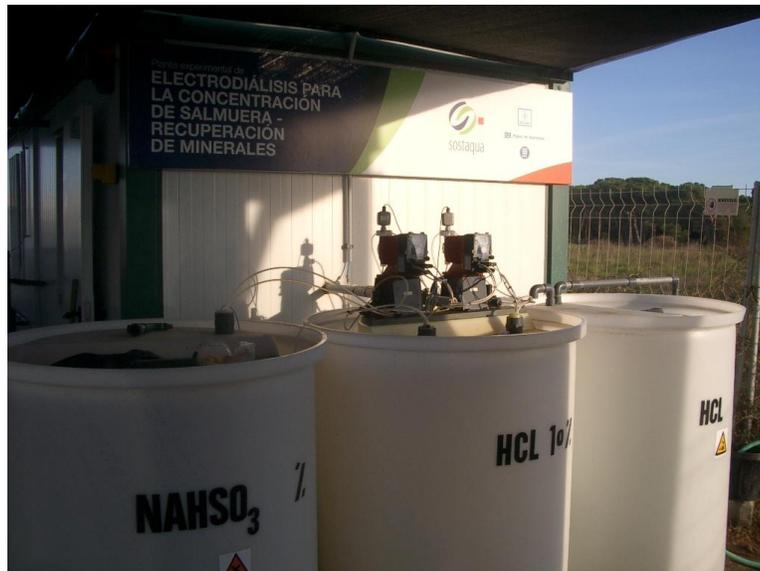
Figura II.15 Tanques de reactivos
