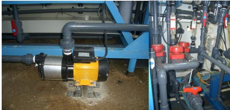
Figura VI.13 Nueva bomba instalada para el caudal del cátodo
