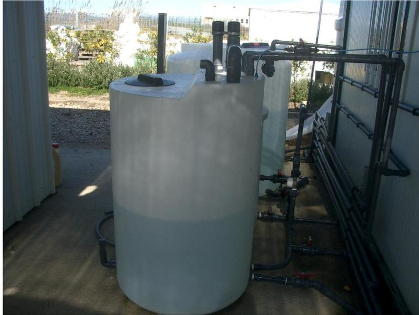
Figura VI.12 Nuevo tanque de concentrado de menos capacidad
