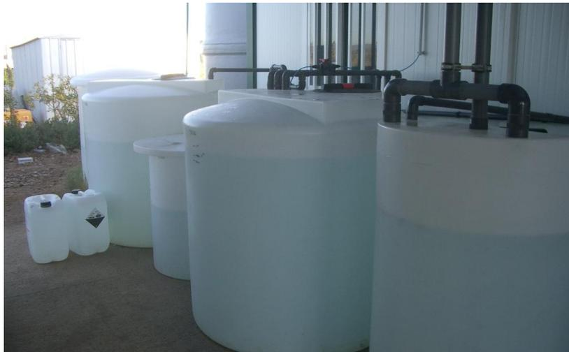
Figura II.16 Tanques de permeado, diluido, producto y concentrado
