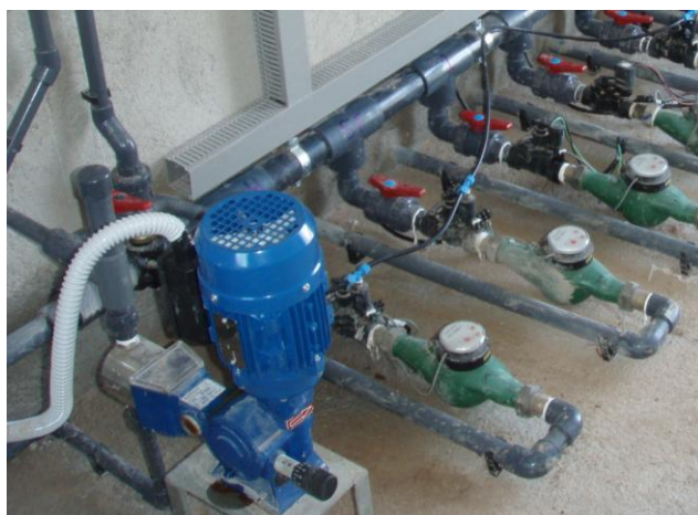
Fotografía 5. 6. Contadores volumétricos de pulsos.
