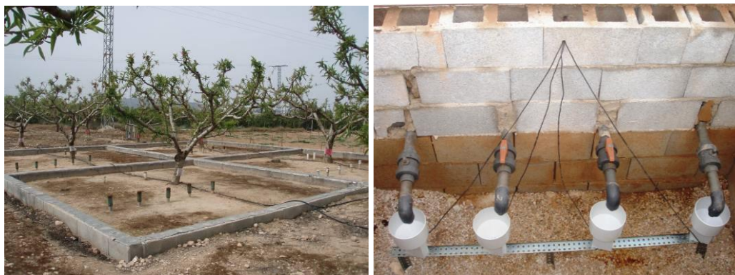
Fotografía 5. 1. Vista general de los lisímetros (Izda.) y sistema de drenaje (Dcha.).
