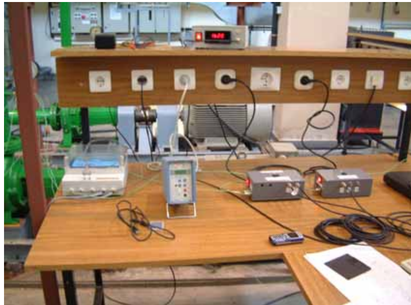
Fig. 4-14. Detalle de amplificadores, Tacómetro, medidor ultrasónico de caudal y cableado.
