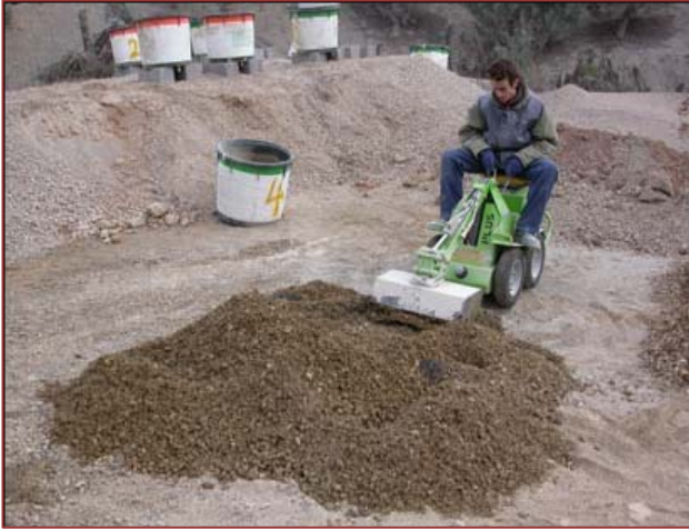
Figura 4.2 Equipo para la dosificación y mezcla de los residuos para la preparación de los sustratos ensayados
