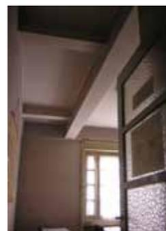
FIG. 83 Pilar e vigas de betão armado visíveis num dos compartimentos
