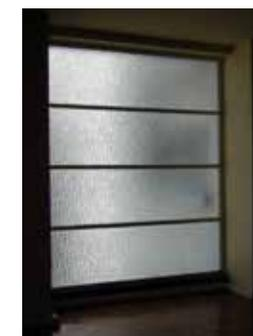
FIG. 185 Janela fixa com caixilho de ferro e vidro fosco também na sala
