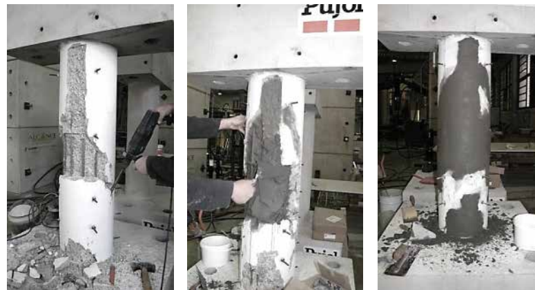
Figura 5-7 Recuperación del hormigón afectado en el pilar reparado
