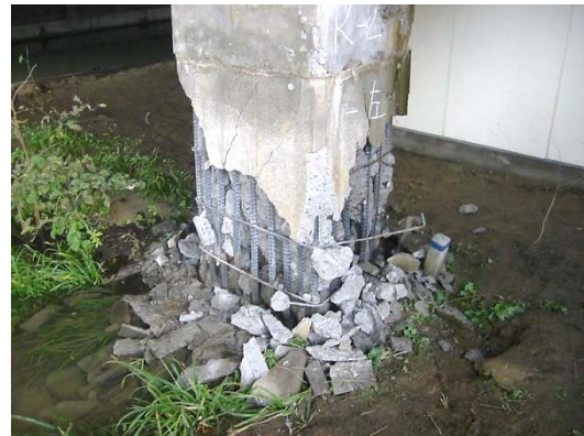
(b) Fallo de columna en viaducto de tren de alta velocidad (Niigata, sismo en Japón 2004) [ASHFORD & KAWAMATA 2004]
