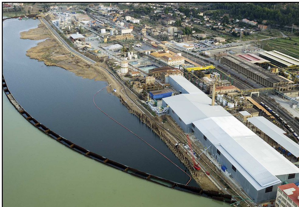
Figura 1.5. Complex industrial ERCROS amb el mur de contenció envoltant les tones de fangs acumulats enfront, en l'embassament de Flix. Font: www.tafyr.es , UTE Ebre Flix 29/01/2013.
