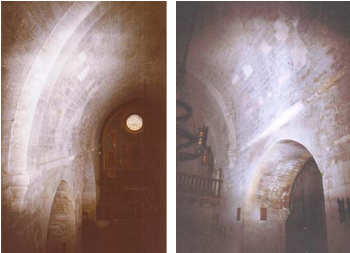
Figs.67 i 68. Santa Maria de Verdú. Interior. Esquerra: Costat de l'evangeli de la nau central on estava instal·lat l'orgue de Francesc Bordons, vist des dels peus de la nau, amb l'arcada ja oberta. Dreta: Costat de l'evangeli de la nau central on estava instal·lat l'orgue, vist des de la capçalera de la nau, amb l'arcada ja oberta. Encara es veuen les marques de l'acoblament de l'orgue a la pedra.
