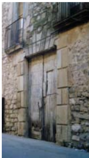
Fig.2. Portalada de la caserna.
