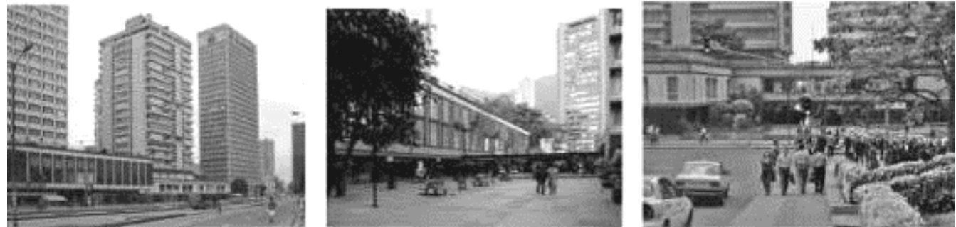
Vistas del conjunto desde la carrera Séptima, desde el espacio libre interior del conjunto Tequendama y del acceso peatonal al conjunto Bavaria. Fuente: Mayorga Fontana, 2008
