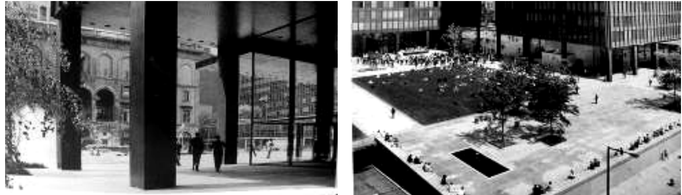
Relación edificio-calle a través de las plantas bajas: Seagram Building New York (1954), Toronto Dominion Center, Chicago, (1963)
