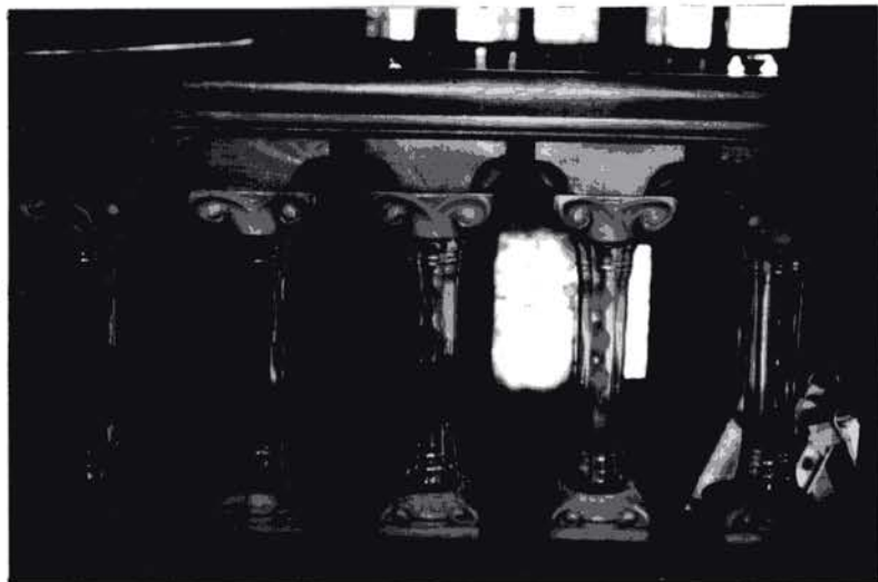
Foto 11 Detall de la balustrada del nivell superior sob- re la sala de la planta baixa, amb columnetes tipus jòniques de vidre i de fusta.
