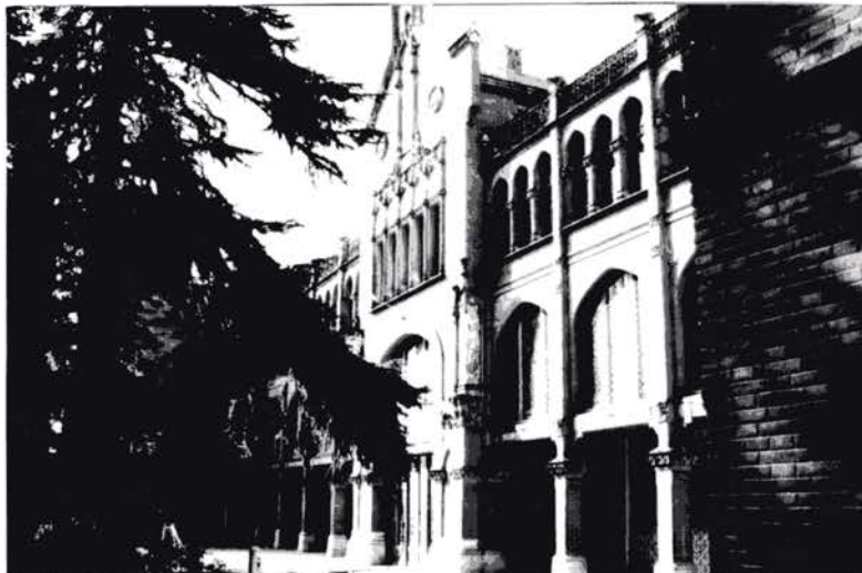
Foto 4 Vista de la part central de la façana posterior del pavelló 5-6.
