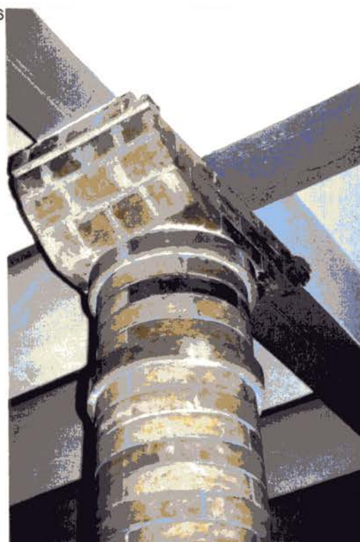
Foto 15 Columna de fosa darrere la columna de guix de la finestra del vestibul d'entrada, amb fust llis i simplificació de volutes al capitell.
