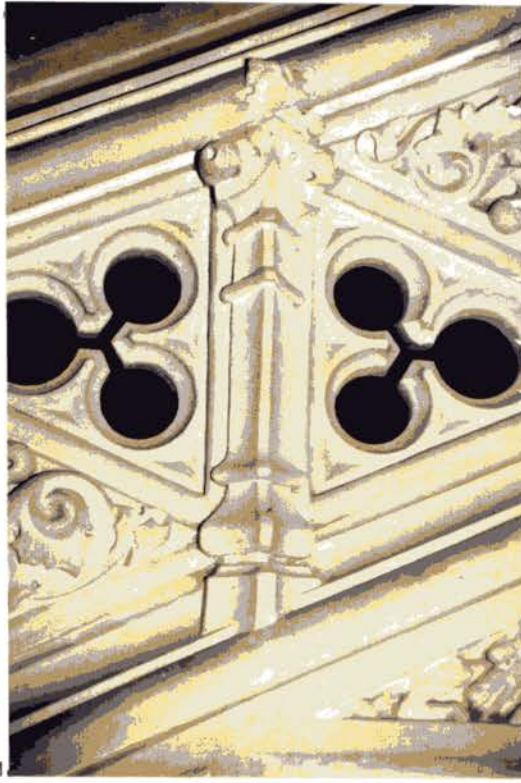
Foto 10 Detall del teginat de fusta que coloreix la gran escala del Seminari amb profusa ornamentació a les columnes volades i a les mènsules amb temes zoomòrfics.
