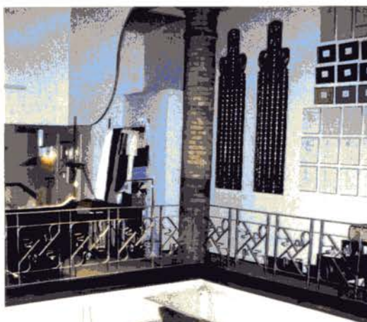
Foto 13 Vista de l'interior de les plantes baixa i soterrani, amb columnes que semblen de maó.
