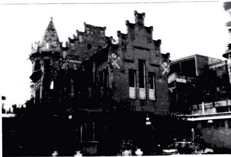
Foto 1 Vista general de la façana posterior de la Casa Roura, en maó vist als murs i ceràmica vidrada a les cobertes.
