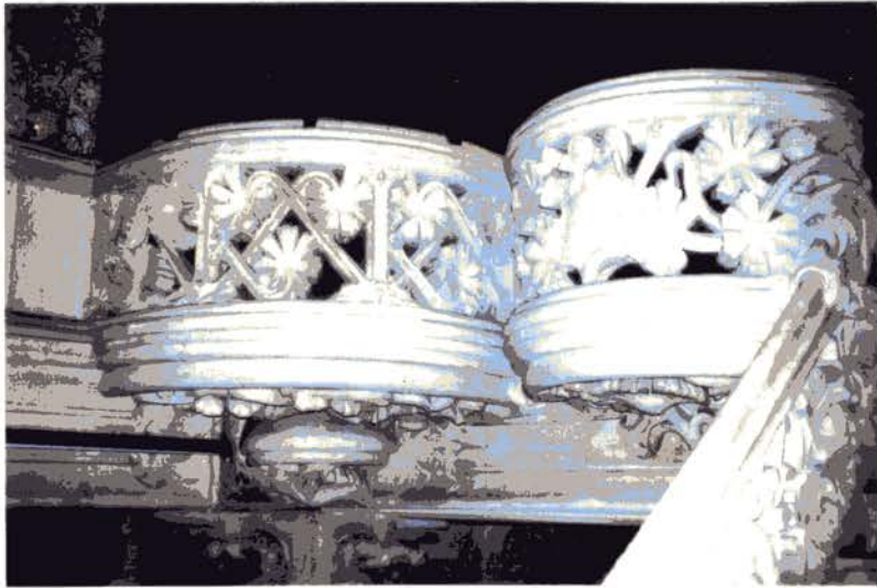
Foto 9 Barana de l'accés a l'habitatge principal sobre escallinata del vestíbul, ornamentada amb formes vegetals obertes en pedra blanca.
